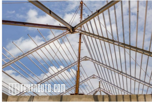
Gambar 3. 16 Konstruksi Atap Baja WF
