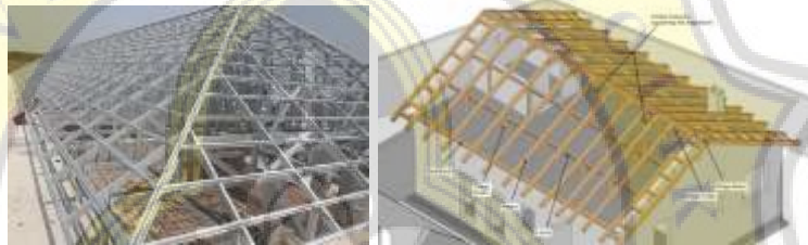
Gambar 3. 14 Konstruksi Atap Baja Ringan
