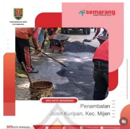
Gambar 4. 18 Pembinaan pada Jalan daerah Mijen
