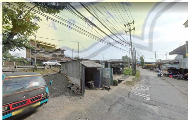
Gambar 2. 20 Tiang Listrik di Kabupaten Demak
