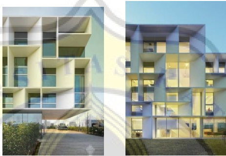
Gambar 108. Tipe Sun Shading Eggcrate Sumber: (Pinterest, 2022)
