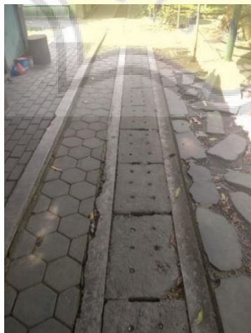
Gambar 2. 12 Saluran Drainase
