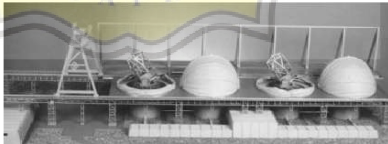
Gambar 127 . Konsep awal VLT untuk operasional di angin bebas. Penutup dari kain untuk melindungi teleskop saat siang hari dan ditarik buka saat malam. Kaca terbuat dari kisi-kisi yang dapat dimiringkan untuk melindungi teleskop dari angin. Pendekatan ini tidak diimplementasikan karena teleskop dan guncangan kaca dari angin ditentukan berlebihan. (Sumber: The design and construction of large optical telescopes, Pierre Y. Bely : 2003)
