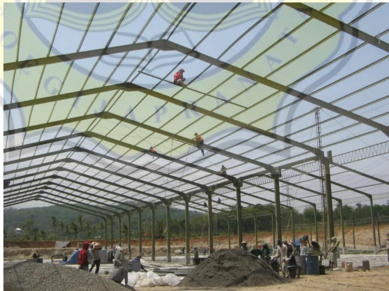
Gambar 6. 12 Struktur Baja Konvensional
