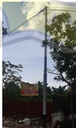
Gambar 54. Jaringan Listrik Sumber: Dokumentasi pribadi
