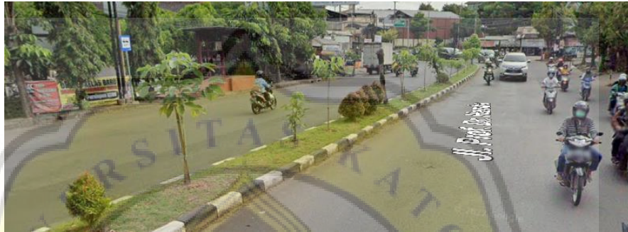
Gambar 39. Kondisi Jalan Akses Utama
