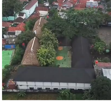
Gambar 5. Foto Tampak Atas Bangunan
