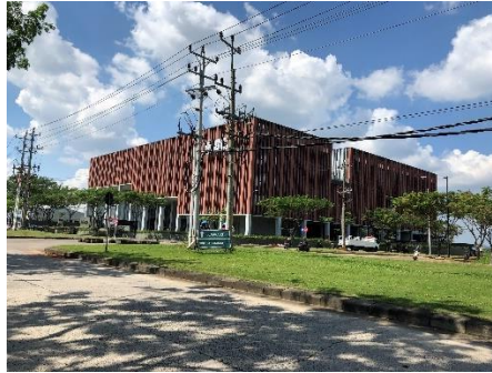
Gambar 8 Gedung Halo BCA
