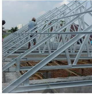
Gambar 6. 2 Struktur Atap Baja Ringan Sumber: Tokopedia.com
