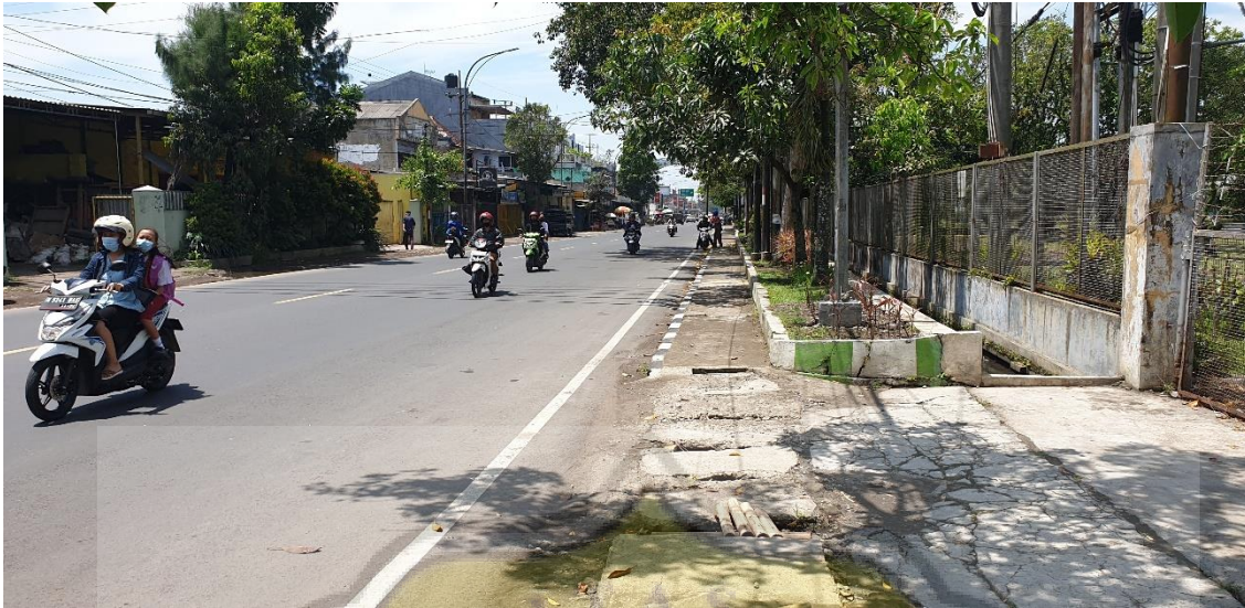
Figure 14 Foto trotoar di seberang tapak
