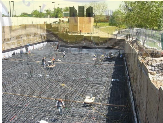
Gambar VI.10 Pondasi Rakit ( Raft / MAT Foundation )
