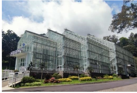
Gambar II.8 Tampak Luar Bangunan Konservatori Kebun Raya Cibodas
