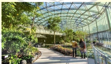
Gambar II.9 Indoor Bangunan Shinjuku Gyo-en Greenhouse, Jepang
