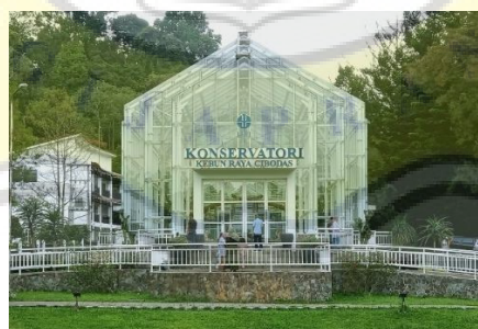
Gambar II.7 Tampak Luar Bangunan Konservatori Kebun Raya Cibodas
