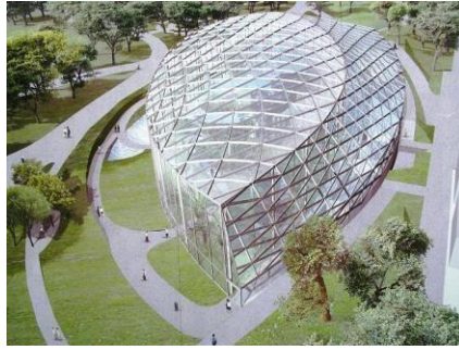
Gambar II.10 Indoor Bangunan Shinjuku Gyo-en Greenhouse, Jepang
