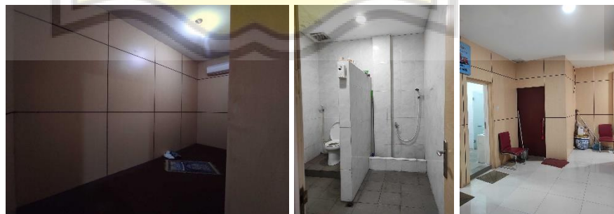
Gambar 20 Ruang-Ruang Penunjang Pusat Kendali smart city Kota Semarang. (Kiri) Musholla, (tengah) Toilet, (kanan) R. Janitor. (Sumber: Dokumentasi Pribadi 31-12-2021)
