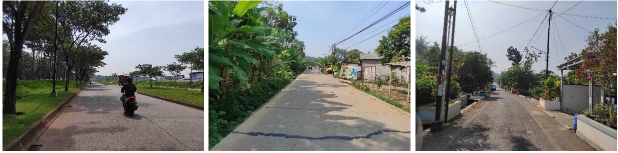
Gambar 23 Contoh kondisi jalan pada Kelurahan Pesantren. (Kiri) Jl. R. M. Hadi Subeno Sosrowardoyo, (tengah) Jl. Perkebunan Pesantren, (kanan) contoh jalan lingkungan (Sumber: Dokumentasi Pribadi 22-7-2022)
