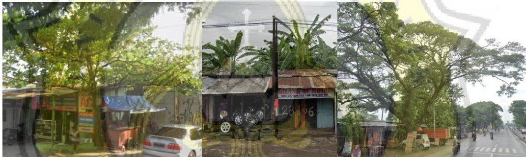
Gambar 3 11 Kondisi Jalan Sumber: Google Maps, 2022
