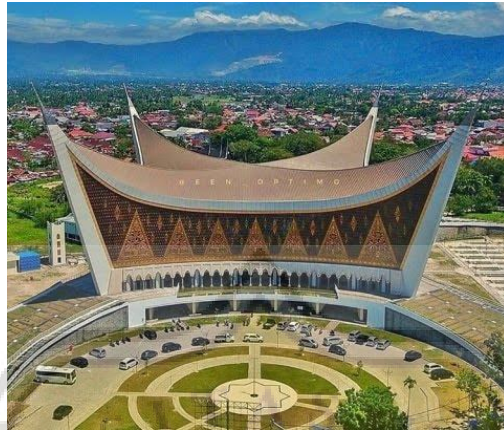
Gambar 47. Masjid Raya Sumatera Barat Sumber : Dokumen Google
