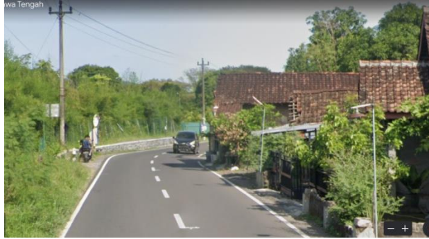
Gambar 2.5.6 – 6 Karakteristik bangunan Sumber Googleearth.com
