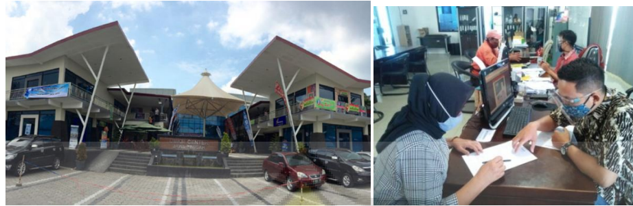
Gambar 2.6 – 9 Gedung UMKM & Ruang Konsultasi
