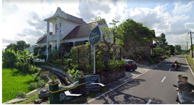
Gambar 2.5.6 – 3 Karakteristik bangunan Sumber Googleearth.com
