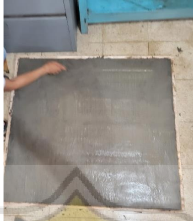
Gambar E.2. Perataan Permukaan Plat Mortar
