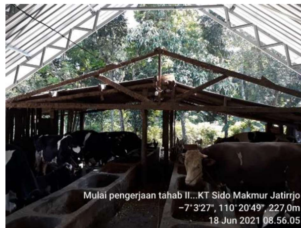
Gambar 1. Renovasi lanjutan dilakukan, tampak perbedaan bangunan lama (lebih rendah atapnya) dan bangunan baru (lebih tinggi atapnya) yang membuat sirkulasi udara menjadi lebih baik
