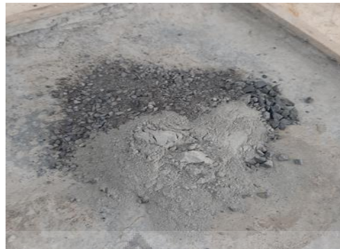
Gambar 3.6 Pencampuran Agregat dan Semen
