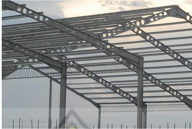
Gambar 47 : Atap Baja WF
