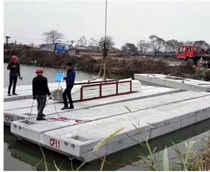
Gambar 85 Ponton Beton Apung
