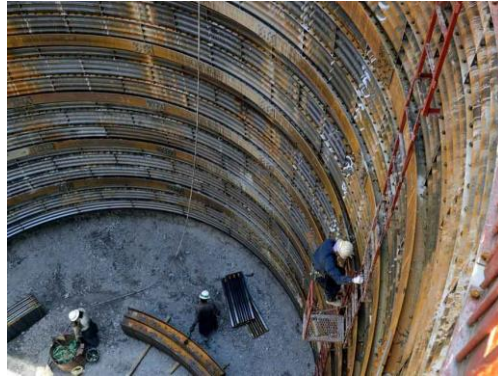
Gambar 61 Struktur Pondasi Kaison
