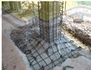
Gambar 6.6 Penggunaan material beton pada struktur bangunan (pondasi)
