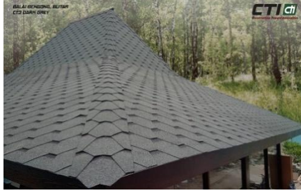
Gambar 6.7 Penggunaan material asphalt pada penutup atap Joglo
