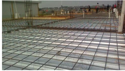
Gambar 3.10 Ilustrasi rangka atap dak beton
