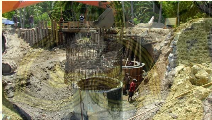
Gambar 58 Pondasi Sumuran
