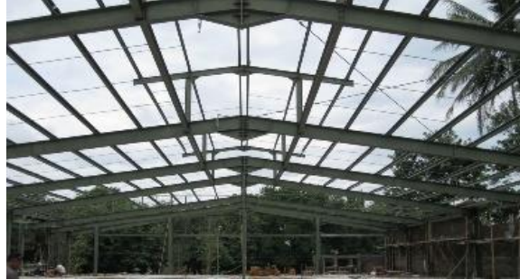
Gambar 6.6 Struktur Rangka Atap IWF
