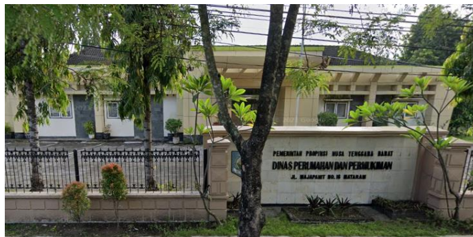
Gambar 77. Kantor Dinas Perumahan dan Permukiman
