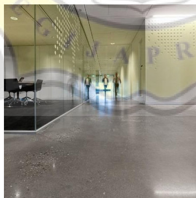
Gambar 62. Penutup Lantai Beton
