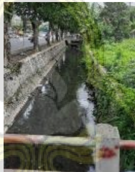
Gambar 3.2. 7. Drainase (Sumber : Dokumentasi Pribadi)
