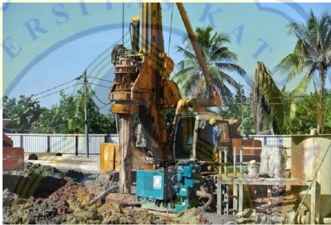
Gambar 66. Pondasi Borepile untuk Konstruksi (sumber : depositphotos.com)
