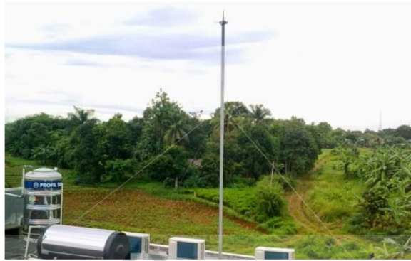
Gambar 82. Penangkal Petir Faraday (Sumber : https://bintangkurniajaya.co.id/sangkar-logam-penangkal-petir-faraday/ )
