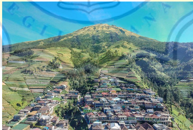
Gambar 5.8 Bangunan Lerengan Gunung Sumbing
