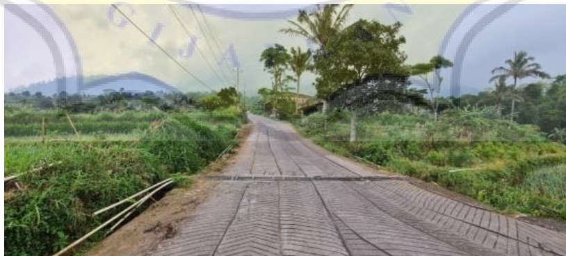
Gambar 3.43 Gambar Jalan Blanten Lor
