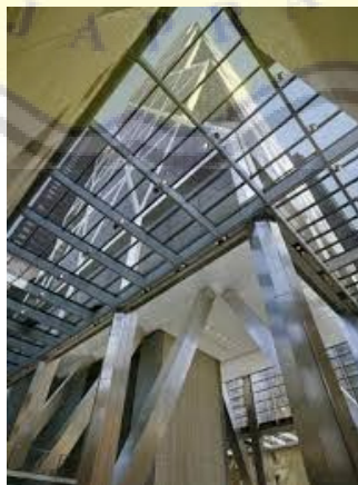
Gambar 67 Struktur atap rangka baja dengan atap kaca
