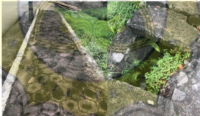
Gambar 3. 13 Kondisi saluran drainase dan trotoar Sumber : Dokumentasi Pribadi, 2022
