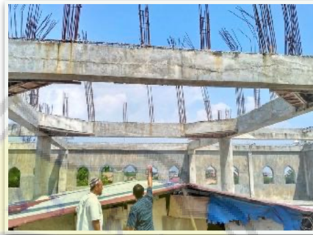
Gambar 94 Contoh Ring Balok Beton Sumber : (Internet)
