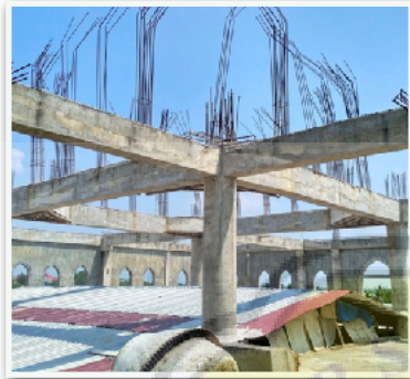
Gambar 93 Contoh Ring Balok Beton Sumber : (Internet)
