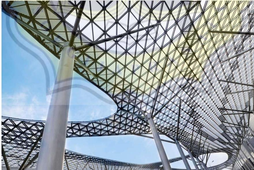
Gambar 25 Struktur Space Frame
