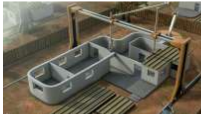
Gambar 6. Printer 3D untuk membangun rumah
