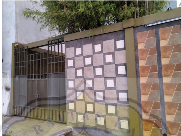
Gambar 3.1 Tampak depan lokasi penelitian
