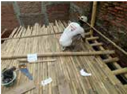
15. PEMASANGAN LANTAI RUMAH BAMBU DARI BILAH BAMBU YANG DIPASANG DI ATAS GELAGAR BAMBU.
