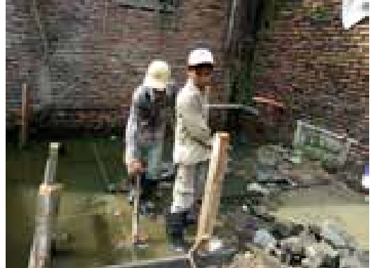
2. PEMBUATAN BATAS BANGUNAN (BOLWPLANK DAN PENENTUAN PONDASI)
