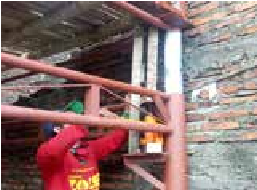
19. RUMAH DINAIKKAN DENGAN DONGKRAK HIDROLIS DI EMPAT SISI.
