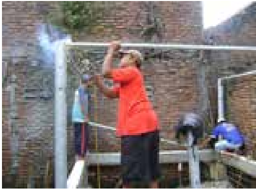
13. PEMASANGAN PIPA GALVANIS DENGAN LAS.
