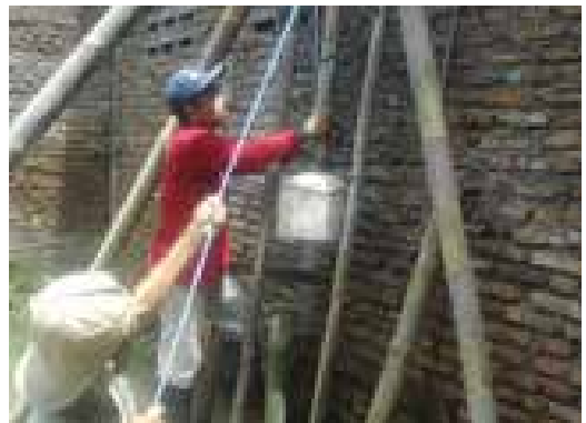
4. PEMASANGAN CERUCUK BAMBU DENGAN SEBAGAI LANDASAN PONDASI. CERUCUK BAMBU DIMASUKKAN KE TANAH DENGAN BANTUAN PILE HAMMER
