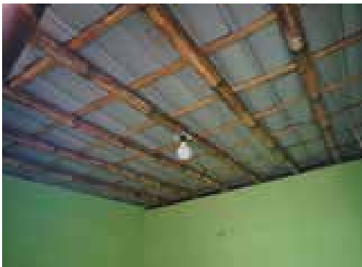
26. PENUTUP ATAP DARI RANGKA BAMBU & GENTENG METAL. UNTUK MENGURANGI PANAS DAPAT DITAMBAHKAN PELAPIS ATAP ALUMINIUM FOIL.
