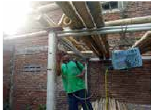
12. PEMASANGAN TIANG SERTA LANDASAN DONGKRAN PADA TIANG BAGIAN LUAR .
