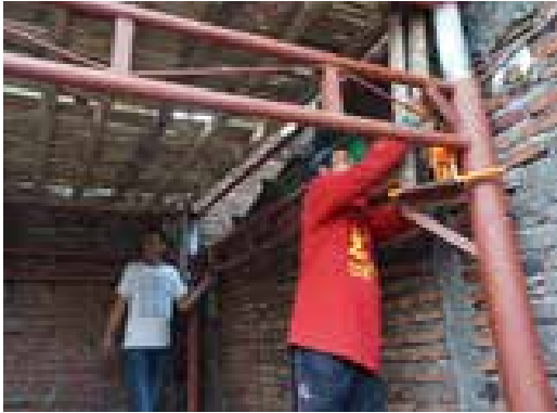
23. MENAIKKAN OMPALIS DENGAN MENGGUNAKAN DONGKRAK DI EMPAT SISI PIPA GALVANIS. KEMUDIAN BATANG KAYU DAPAT DIGUNAKAN UNTUK MENAHAN LANTAI.
