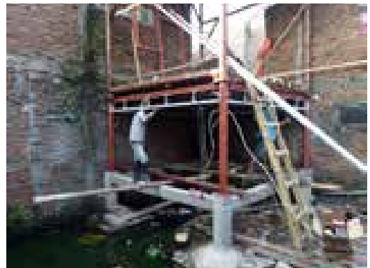
16. PEMASANGAN ATAP BANGUNAN SEBELUM UJI TIANG HIDROLIS DILAKUKAN.
