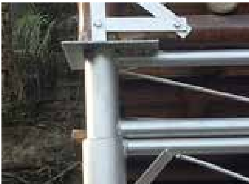
21. DETAIL HUBUNGAN PIPA GALVANIS 3" DAN REGEL.
