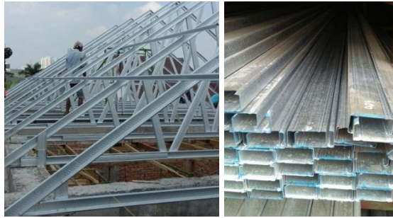
Gambar III.21 : Rangka Atap Baja Ringan
