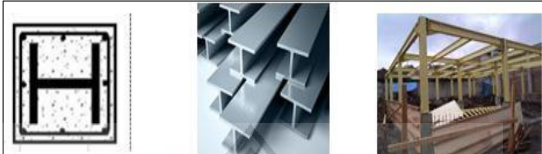
Gambar III.16 : Baja HWF Sebagai Kolom
