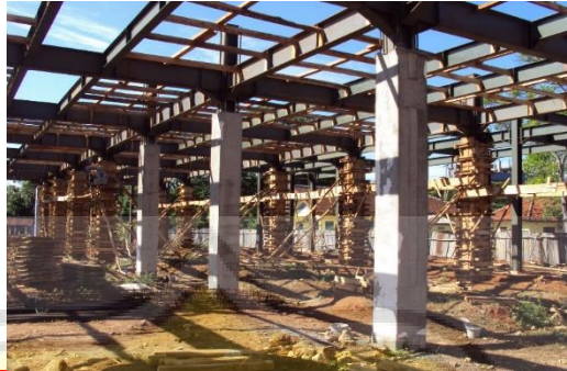
Gbr 22. Kolom baja Sumber : Konsep PTSB VI
