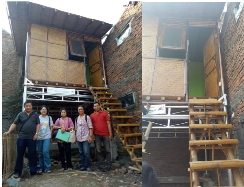
Gambar-5: Tampak bangunan rumah panggung hidrolis Sumber: Peneliti 2018
