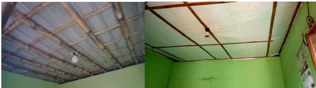
Gambar-16: Penambahan lapisan atap bagian dalam dengan aluminium foil Sumber; Peneliti, 2019
