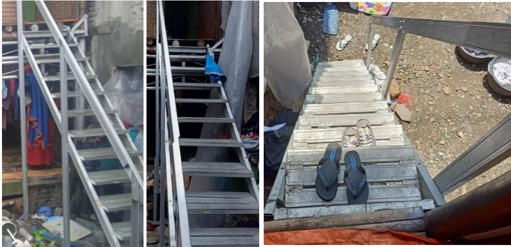
Gambar-18: Penggantian tangga dengan bahan baja ringan Sumber; Peneliti, 2021
