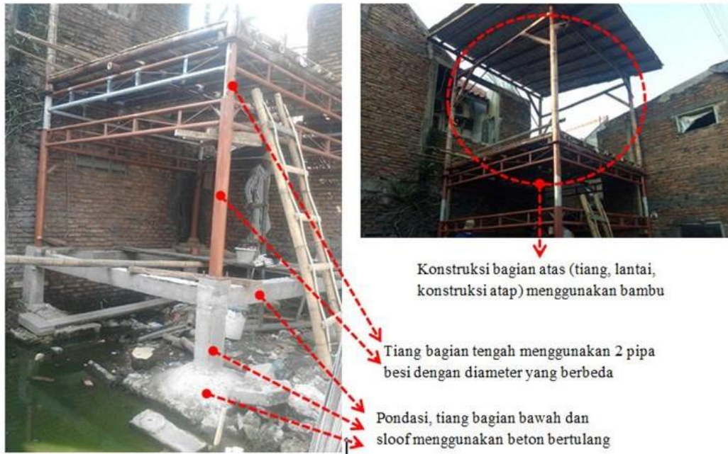
Gambar-4: Konstruksi rumah panggung hidrolis Sumber: Peneliti, 2018
