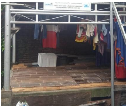
Gambar-19: Pembuatan alas kolong Rumah Panggung Hidrolis Sumber: Peneliti, Desember 2021
