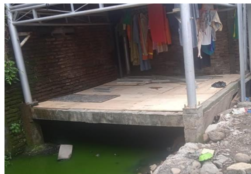
Gambar-19: Pembuatan alas kolong Rumah Panggung Hidrolis Sumber: Peneliti, Desember 2021
