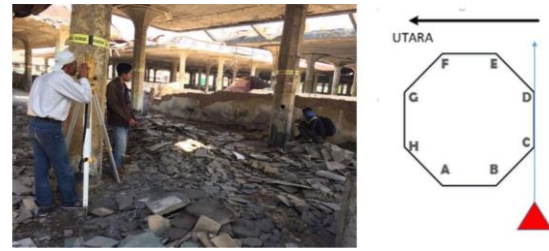
Gambar 7. Pengukuran kemiringan untuk arah barat-timur. (Sumber: Sandi Darma, 2017)
