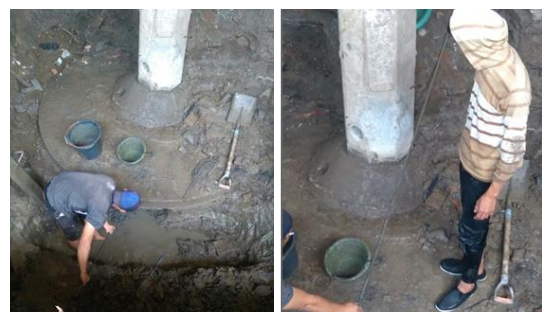
Gambar 27. Proses ekskavasi pencarian pondasi. (Sumber: Sandi Darma, 2017)
