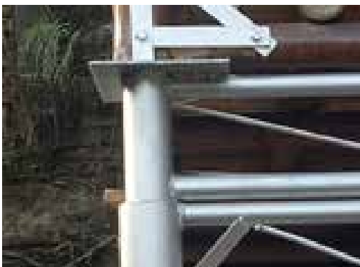
21. DETAIL HUBUNGAN PIPA GALVANIS 3" DAN REGEL.
