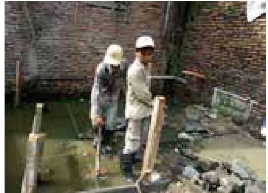
2. PEMBUATAN BATAS BANGUNAN (BOLWPLANK DAN PENENTUAN PONDASI)
