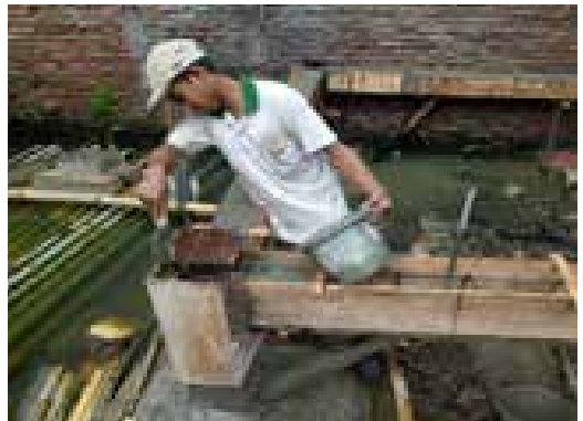
8. PENGEORAN SLOOF DAN KOLOM BETON BERTULANG.
