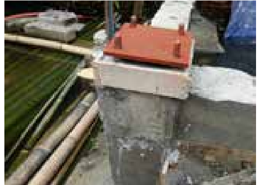
10. PLAT DUDUKAN UKURAN 25 CM X 25 CM UNTUK PIPA GALVANIS UKURAN 4"
