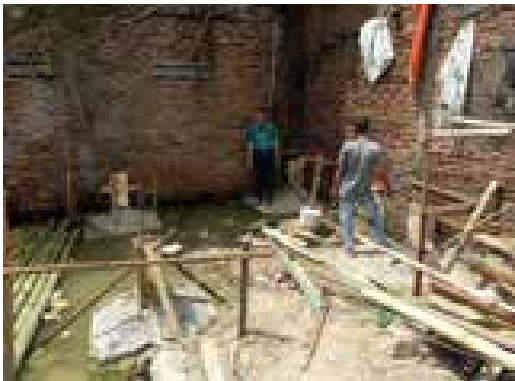
7. PEMASANGAN CETAKAN PAPAN KAYU UNTUK MEMBUAT KOLOM BETON BERTULANG.
