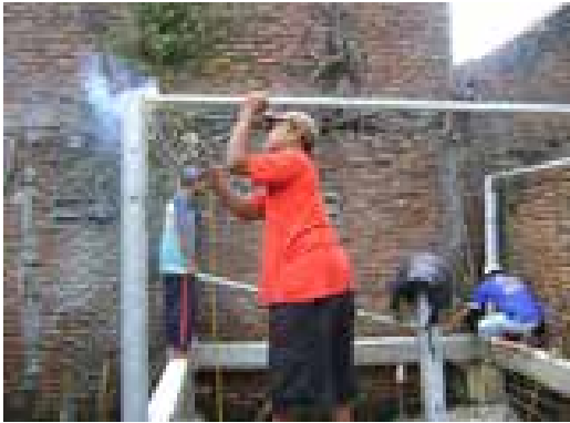
13. PEMASANGAN PIPA GALVANIS DENGAN LAS.
