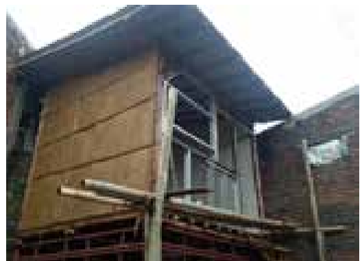
22. PENUTUP DINDING DARI HOLLOW GALVANIS, ANYAMAN BAMBU DAN KALSIBOARD.
