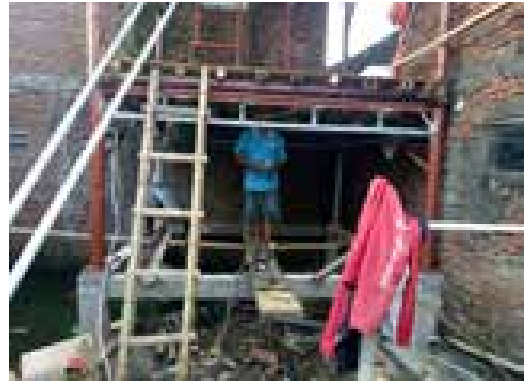
18. PENAMBAHAN REGEL UNTUK MEMPERKUAT LANTAI OMPALIS.
