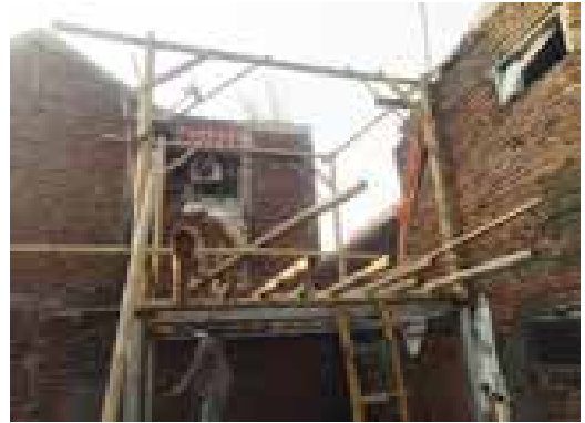
14. PEMASANGAN TIANG BAMBU SEBAGAI LANDASAN LANTAI DAN KOLOM DINDING RUMAH.
