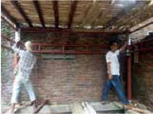
17. UJI COBA TIANG HIDROLIS YANG HARUS DILAKUKAN OLEH SATU ORANG PADA TIAP TITIK TUMPUAN/TIANG.
