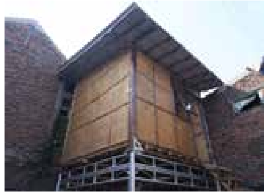
24. PENUTUP ATAP DARI RANGKA BAMBU & GENTENG METAL. UNTUK MENGURANGI PANAS DAPAT DITAMBAHKAN PELAPIS ATAP ALUMINIUM FOIL.
