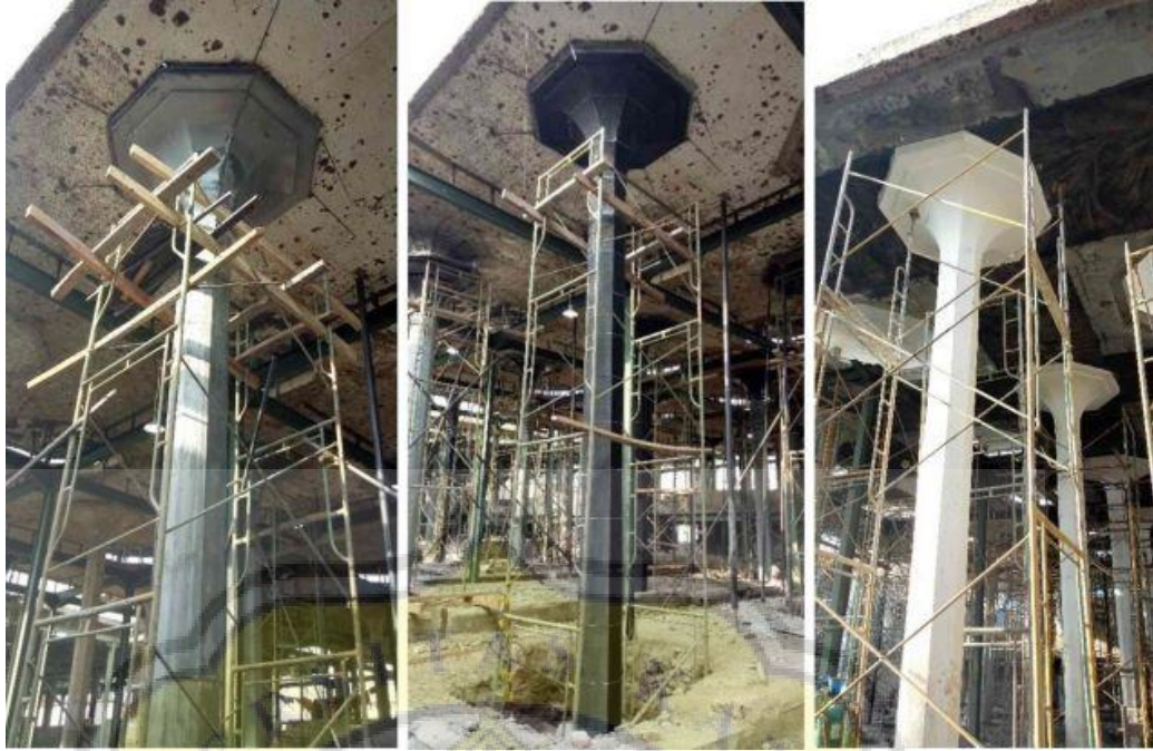
Gambar 4.78. a) Kolom cendawan yang telah selesai di grouting , b) Kolom cendawan yang telah selesai di lapis FRP, c) Kolom cendawan yang telah selesai di cat.
