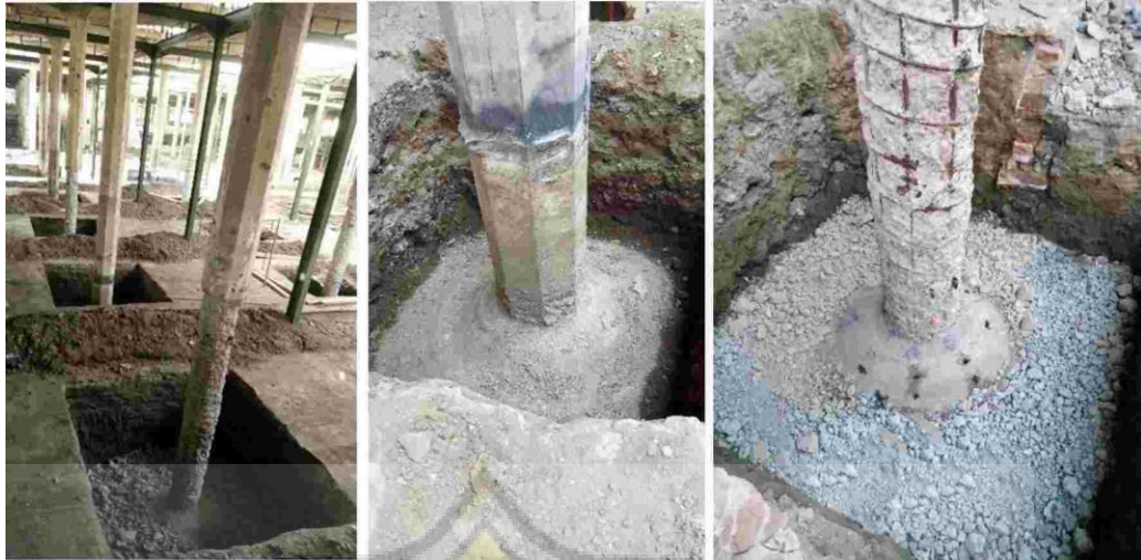
Gambar 4.74. a)Galian disemua titik kolom, b)Telapak pondasi, c) Setelah kolom dikupas selimut betonnya.
