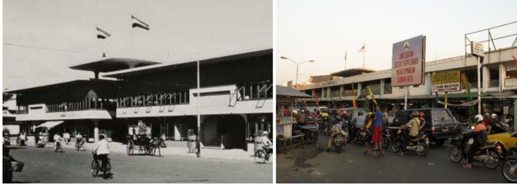
Gambar 4.10. a) Tampak Utara tahun 1939, b) Tampak Utara tahun 2005, tampak asli sudah tertutup bangunan tambahan dari beton. Sumber: Krisprantono, 2017
