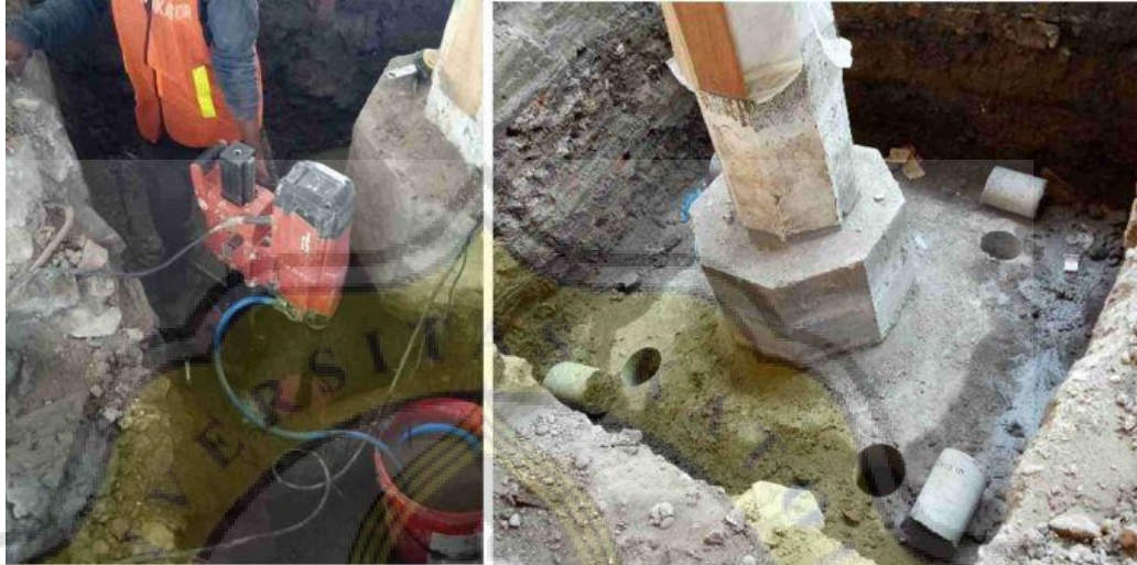
Gambar 4.87. a) Coring pada telapak pondasi, b) Hasil coring telapak pondasi. Sumber: Sriwati Purnomo, 2018
