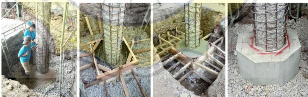
Gambar 4.75. a)Pemasangan tulangan baru, b)Pemasangan begisting pangkal kolom, c) pengecoran pangkal kolom, d)Hasil akhir pangkal kolom.
