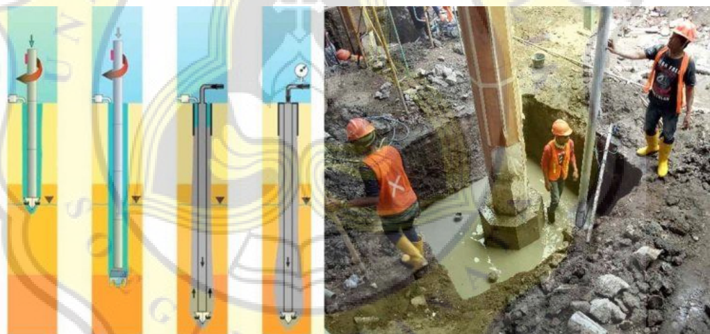
Gambar 4.88. a) Coring pada telapak pondasi (Sumber: Ivan Sandi Darma, 2018) b) Pemasangan besi galvanis, (Sumber: Sriwati Purnomo, 2018)
