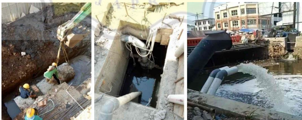
Gambar 4.56. a) Perbaikan saluran air tahun 2019, b) Sump pit , c) Pipa pembuangan akhir di kali Semarang
