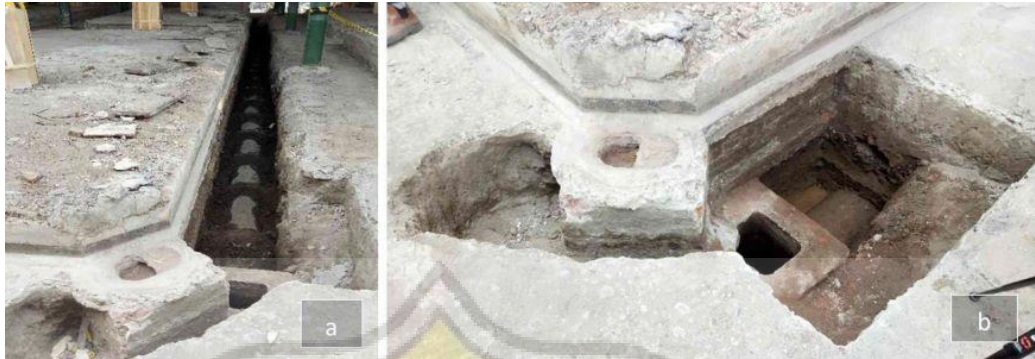
Gambar 4.19. a) Lubang saluran di dalam bangunan pasar Johar, b) Detail lubang saluran pada lantai.
