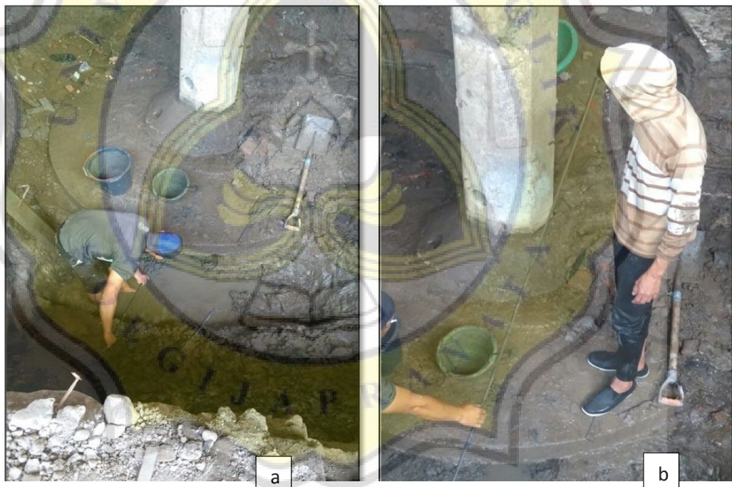
Gambar 4.35. a)Penggalian pencarian pondasi. b) Pengukuran diameter pondasi. Sumber: Ivan Sandi Darma, 2017
