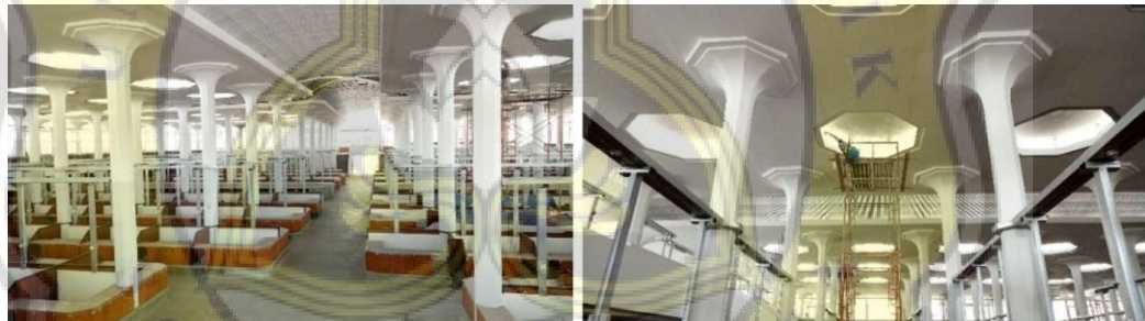
Gambar 4.54. a) Ruang dalam pasar Johar, b) Kolom cendawan dan rumah angin pada atap, tahun 2019 Sumber: Sriwati Purnomo, 2019
