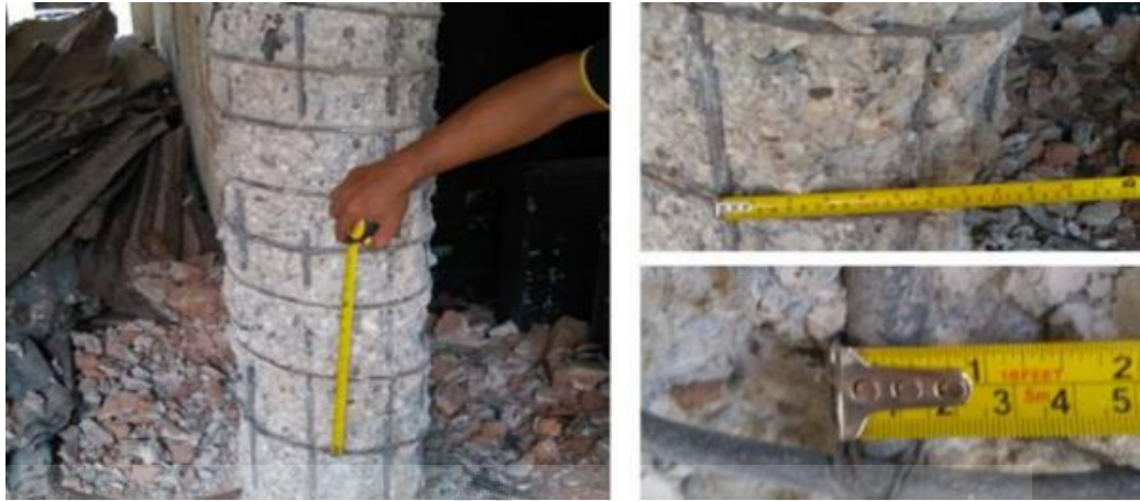
Gambar 4.33. Pelaksanaan chipping pada kolom Sumber: Ivan Sandi Darma, 2017.
