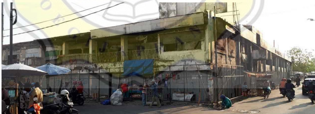
Gambar 4.12. Bangunan tambahan dilihat dari jalan H.Agus Salim(sisi Timur) Sumber: Kayu Aji Abadi, 2017
