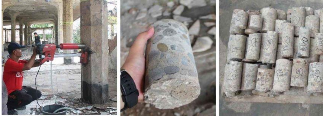
Gambar 4.41. a) Core drill pada kolom, b) Hasil coring , c) Sampel siap uji. Sumber: Ivan Sandi Darma, 2017.
