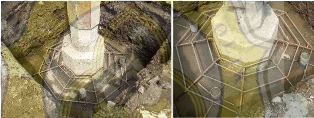
Gambar 4.90. Tulangan penebalan pada telapak pondasi. Sumber: Sriwati Purnomo, 2018
