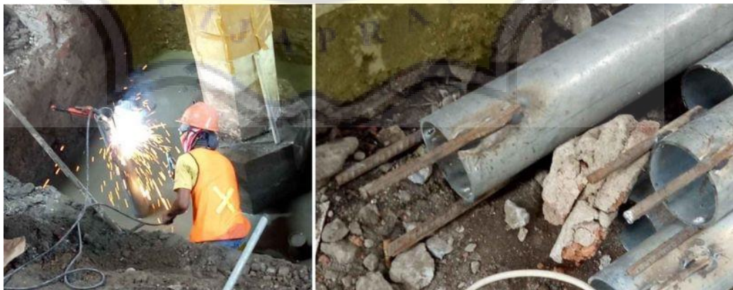
Gambar 4.86. a) Pengelasan penyambungan besi galvanis, b) Besi galvanis 4 inch yang siap disambung. Sumber: Sriwati Purnomo, 2018
