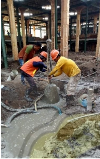
Gambar 4.82. Pembuatan mockup micropiles Sumber: Sriwati Purnomo, 2018
