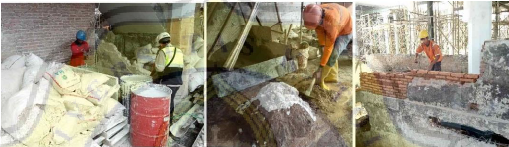
Gambar 4.66. a)Tempat perendaman batu gamping, b) Pencampuran adukan, c) Pemasangan bata dengan bligon. Sumber: Sriwati Purnomo, 2018.
