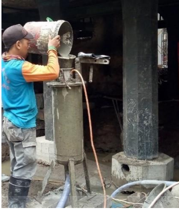
Gambar 4.89. Penggunaan tabung injeksi. Sumber: Sriwati Purnomo, 2018
