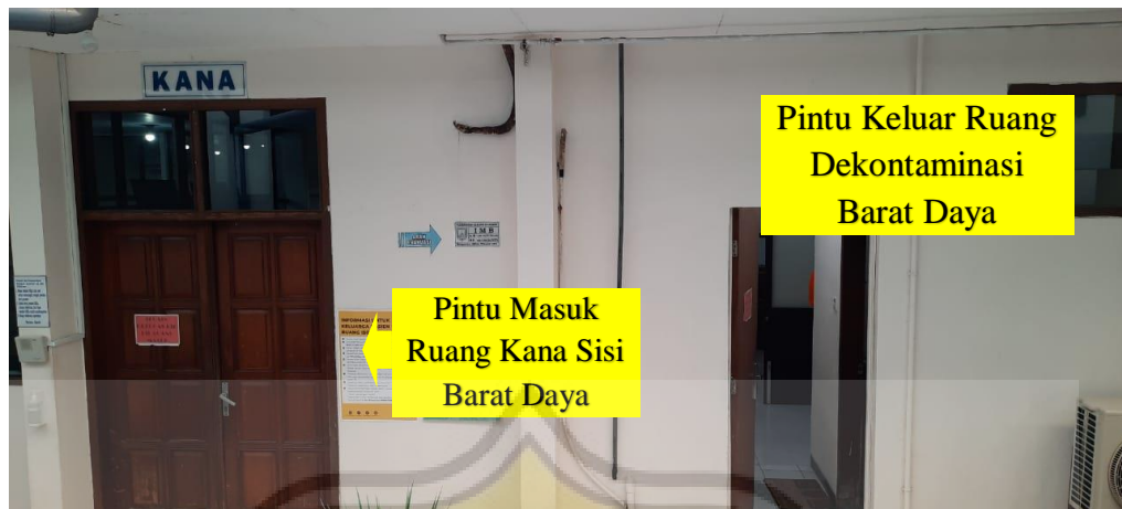
Gambar IV.3 Tampak Sisi Barat Daya Ruang Isolasi Khusus COVID-19, Kana Sumber: Survei Lapangan
